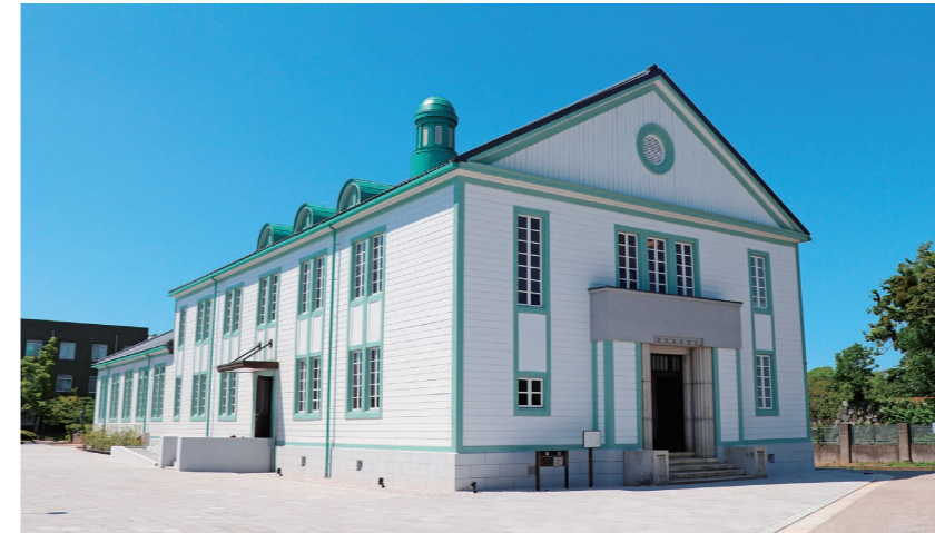
彦根高等商業学校が開校した翌年(1924年)に建築された滋賀大学講堂(彦根キャンパス)。登録有形文化財
