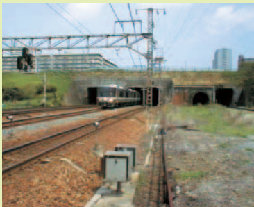
J R 琵琶湖線津川トンネル
