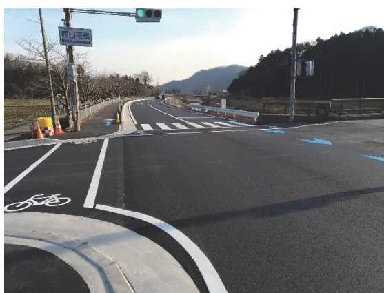
図 9：矢羽根型マークの設置
